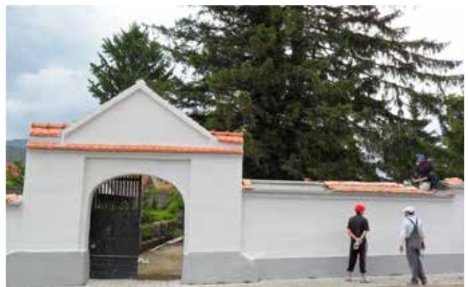
Die neuen Dachziegel sollen mehr Wasserschutz bieten
