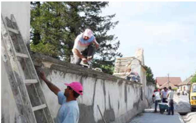
Handwerker bei ihren ersten Renovierungsschritten an der Mauer
