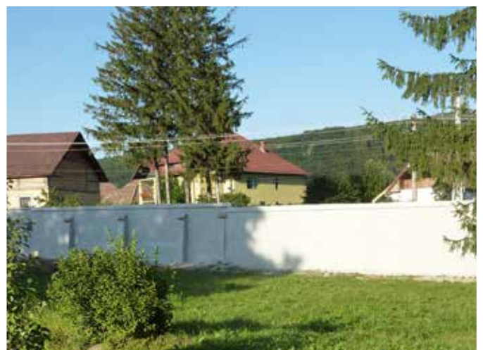
Die fertig renovierte innere Friedhofsmauer
