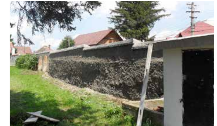
Erste Schritte bei der Renovierung des inneren Mauerwerks
