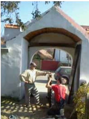
Montage des neuen Friedhofstores am 30. Oktober 2013
